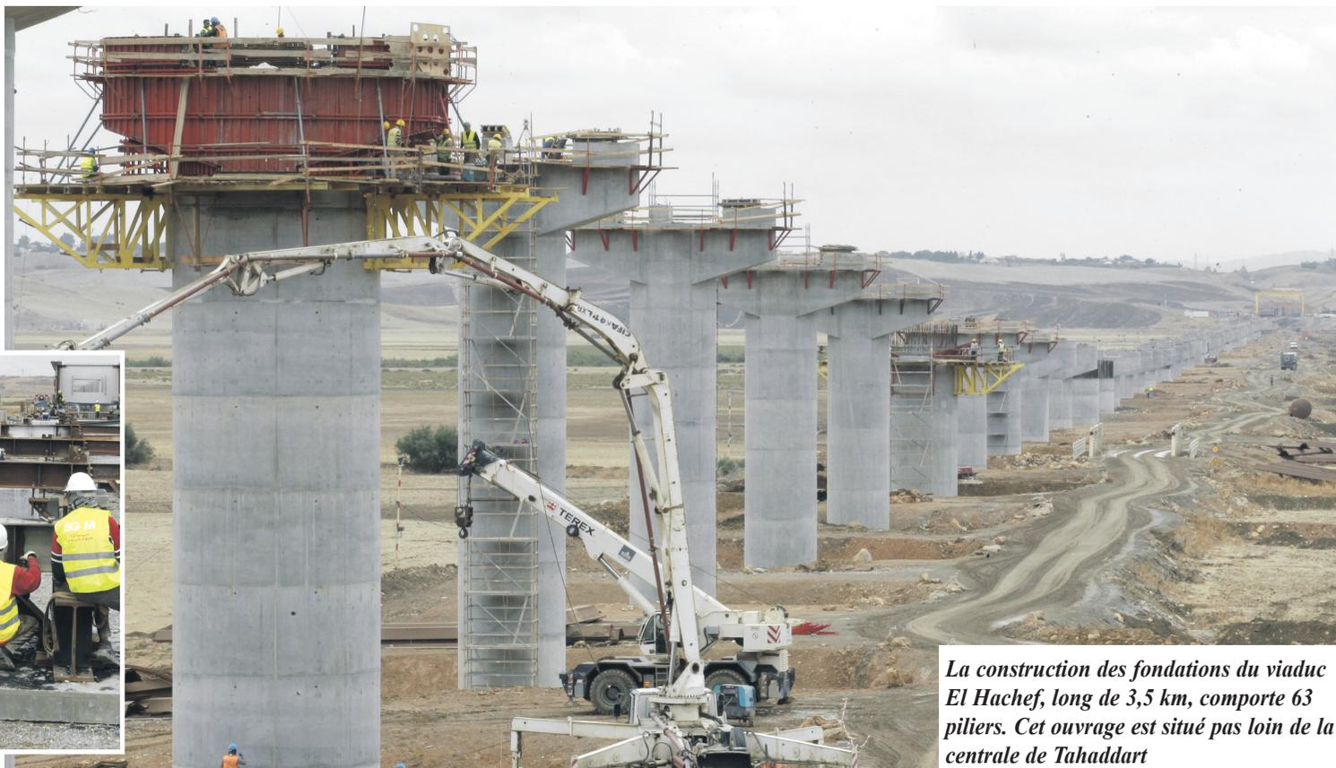
La construction des fondations du viaduc El Hachef, long de 3,5 km, comporte 63 piliers. Cet ouvrage est situé pas loin de la centrale de Tahaddart
