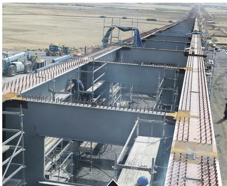
Des barres de fer sont soudées pour constituer l'armature qui sera posée sur les piliers. Les rails du chemin de fer seront entreposés sur cette armature
