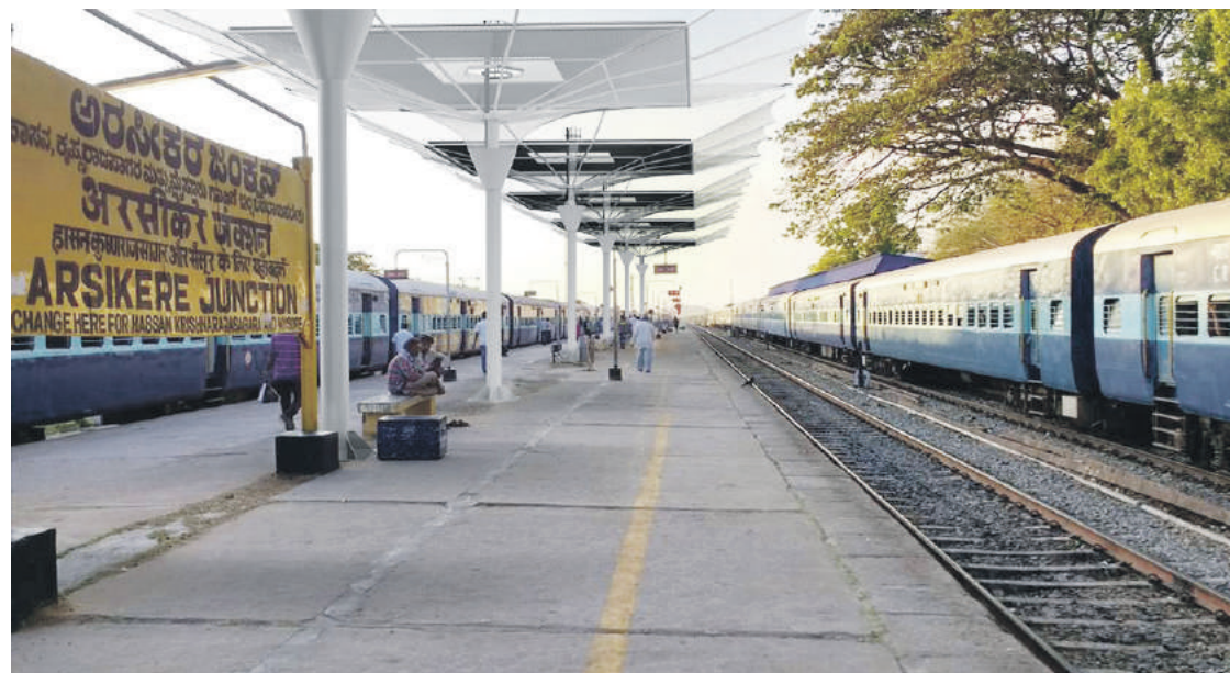
L'ombrelle en acier inoxydable comporte des modules solaires selon une disposition brevetée qui permet à l'eau de s'écouler lors des pluies. Le système collecte et filtre ainsi 45.000 litres d'eau de pluie tandis que les panneaux solaires fournissent une capacité de 400 watt peak (kWp) de lumière et d'énergie renouvelable (Ph. ThinkPhi)
