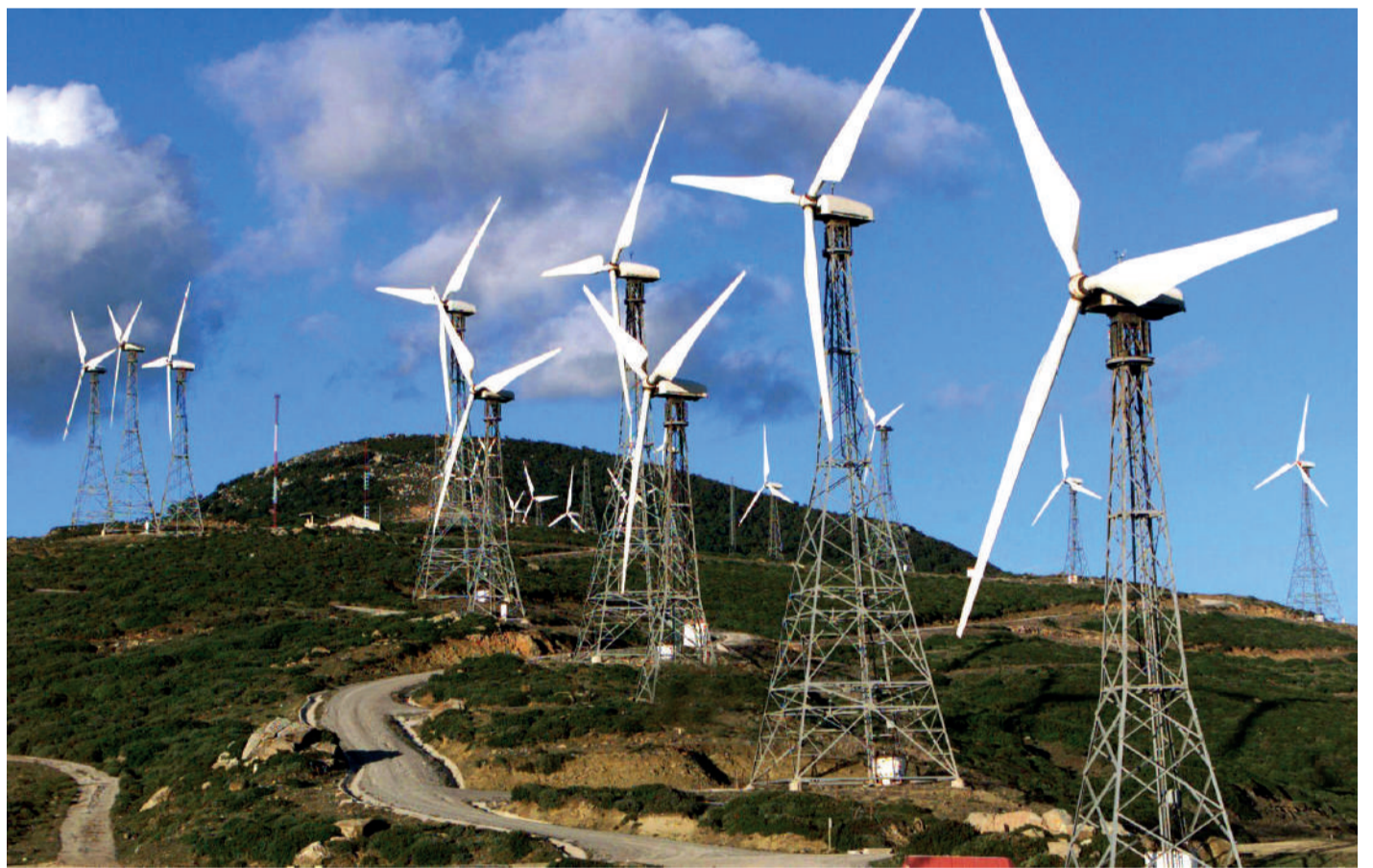
Le Maroc dispose d'un potentiel en énergies éolienne et solaire exceptionnel, estimé à environ 500 térawatts heure. L'éolien onshore a un potentiel de 350 terawatts/heure et le solaire photovoltaïque un potentiel de 150 TWh. Le potentiel de l'éolien offshore est équivalent (Ph. DR)
