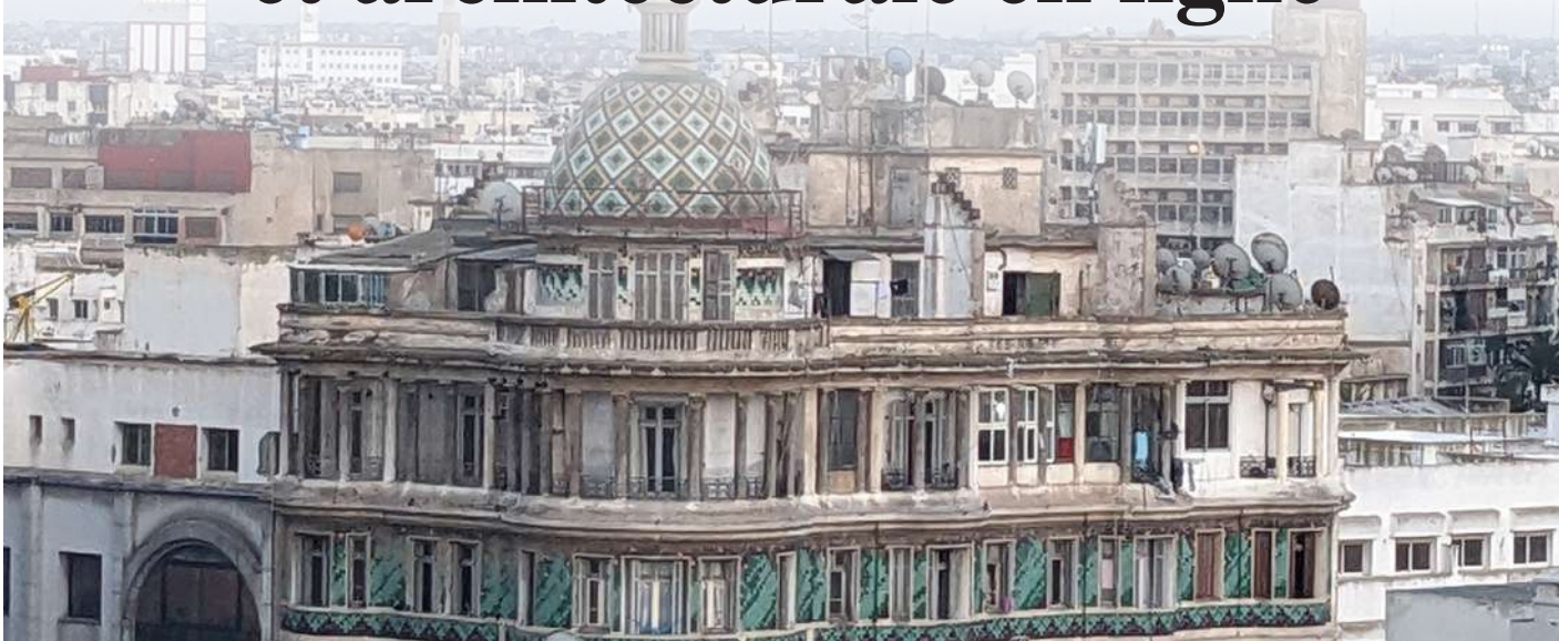
Immeuble rue Hassan Sghir Bd Mohamed V à Casablanca. Inscrit au patrimoine de la ville (Ph. Faquih)
