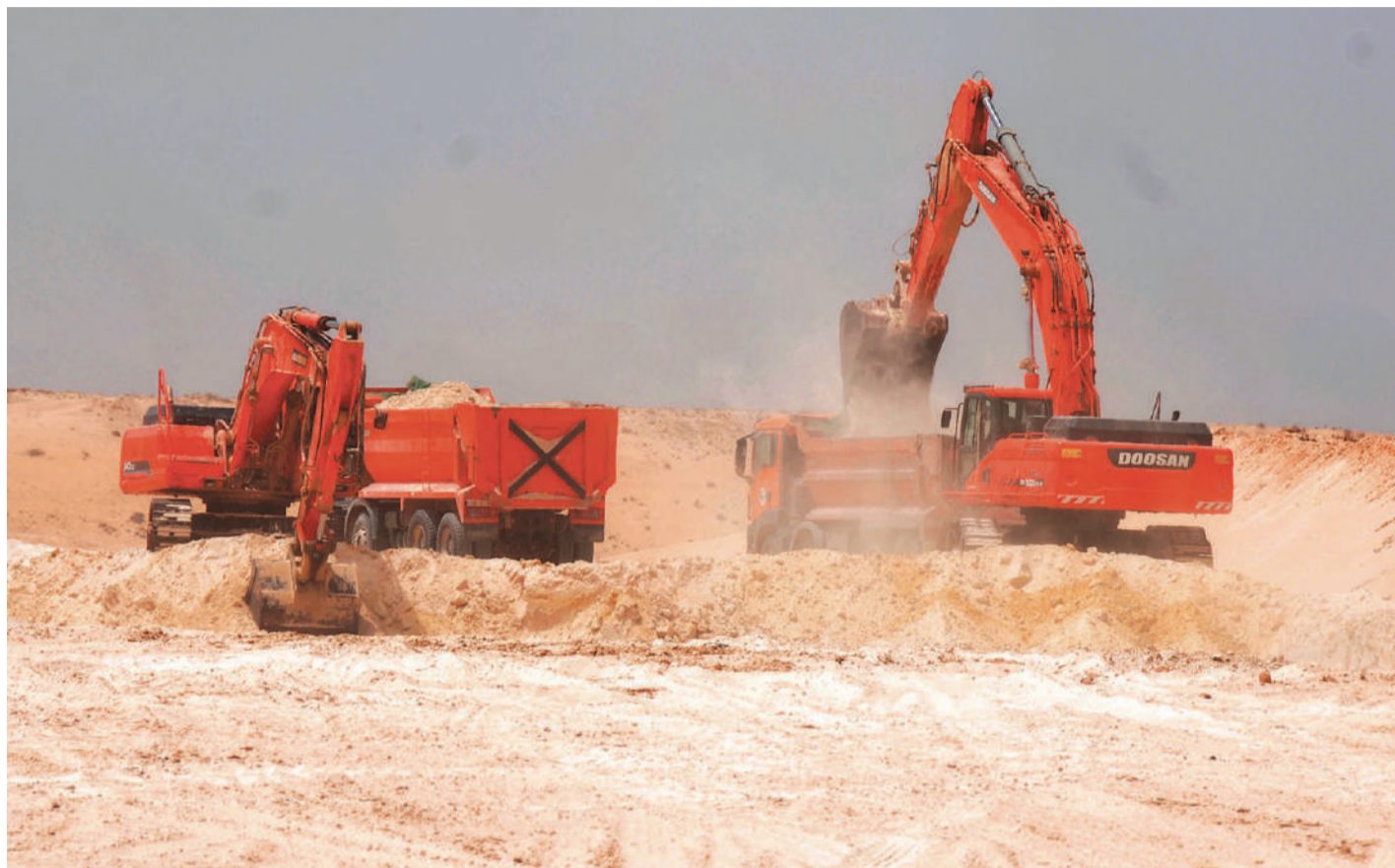
Après l'attribution du marché de construction du nouveau port en eaux profondes, les travaux ont déjà commencé sur place. Près de 7 kilomètres de routes ont été aménagés vers le site du nouveau port. Ce trajet permettra essentiellement l'accès des engins nécessaires aux travaux de construction de ce méga-chantier (Ph. Mofik)
